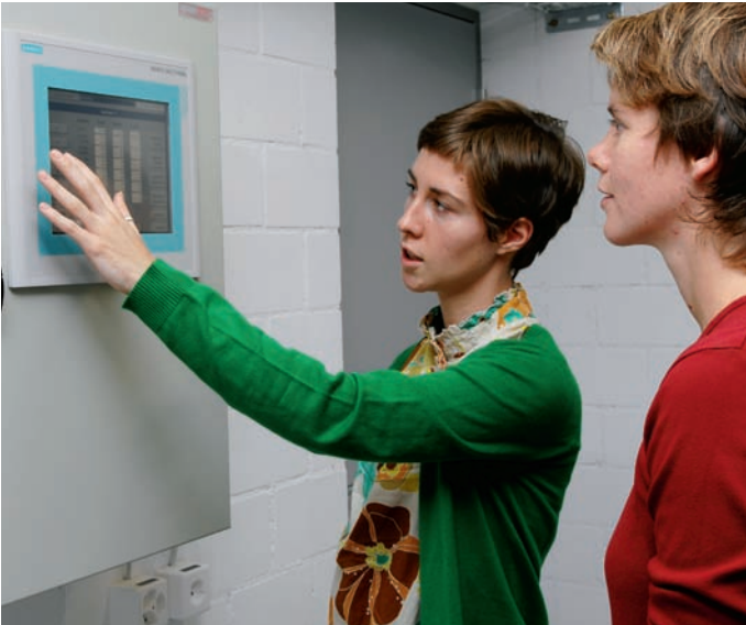
Nicht für immer weggespült: Ein digitaler Zählapparat registriert in der Eawag Datum und Zeitpunkt jeder Spülung (Foto Ruedi Keller)
