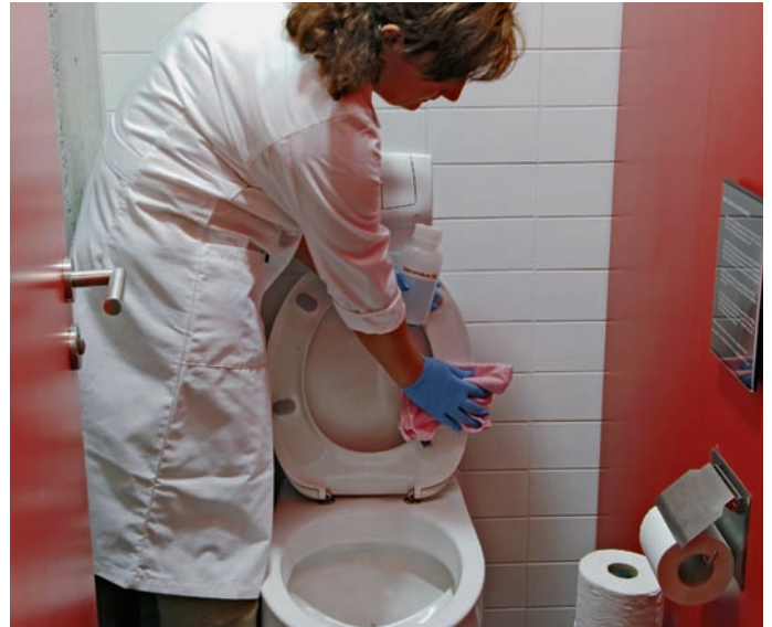
Die richtige Mischung: NoMix-WCs reinigt man z.B. mit 10 % Zitronensäure und Mikrofasertuch, um den Urin nicht zu vergiften (Foto Ruedi Keller)
