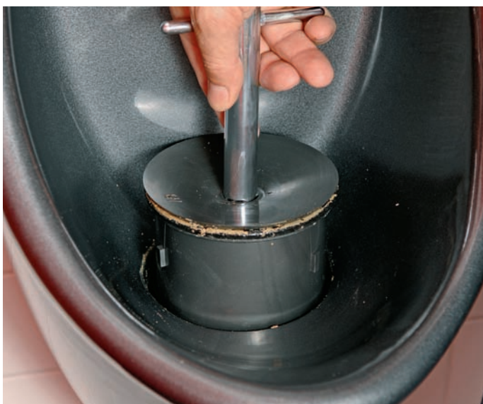
Ohne Wartung läuft nichts (ab): Urinale müssen gemäss Herstellerangaben gewartet werden, um Verstopfungen vorzubeugen (Foto Ruedi Keller)
